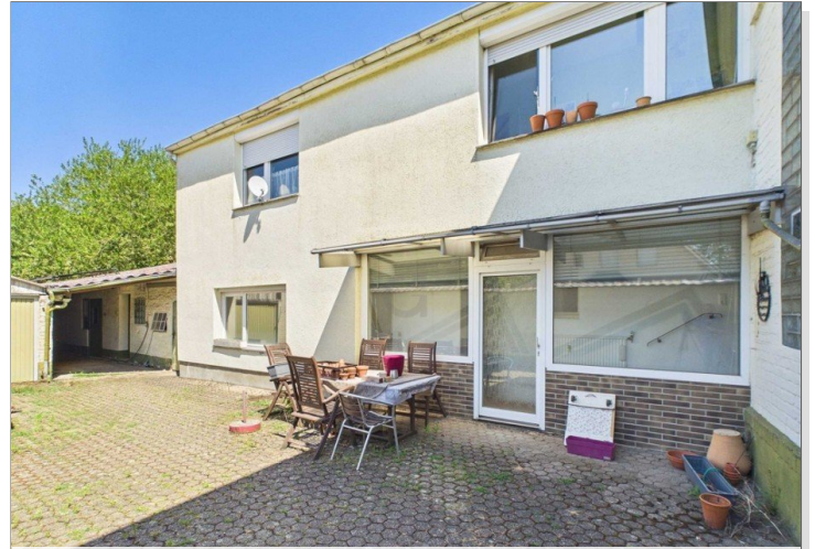
Ansicht seittl. Anbau
