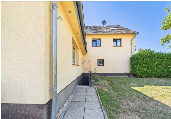
Rückansicht Haus und ELW - Abgang Keller
