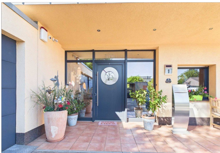
Zugang zum Haupthaus
