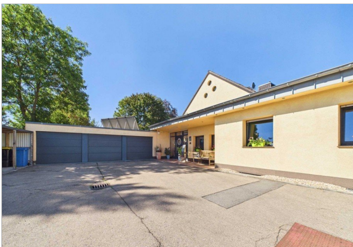
Vorplatz m. Garagen
